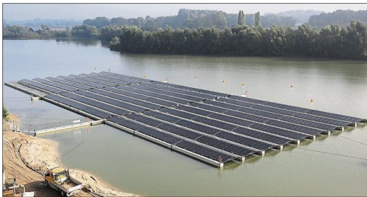
Schwimmende Solaranlagen könnten auf künstlichen Gewässern, also Baggerseen oder Kiesgruben, errichtet werden. Sie hätten ein deutschlandweit Stromerzeugungspotenzial von 20 Gigawatt.
